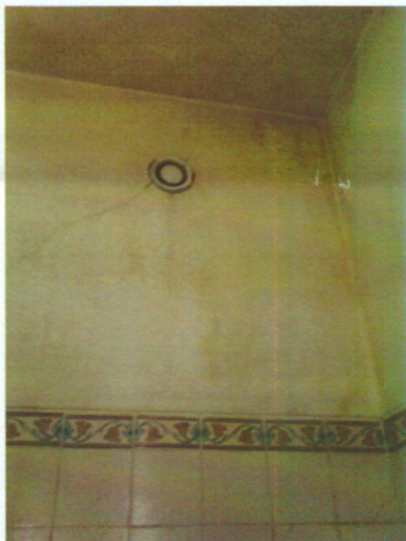
Ilustrações 1 e 2 - Ausência de higienização das hotes das instalações sanitárias.
