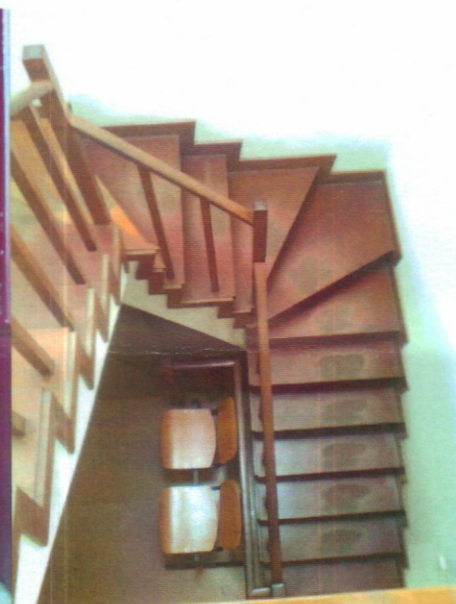
Ilustração 17 e 18: Evidência de escadaria íngreme e não regulamentares.
