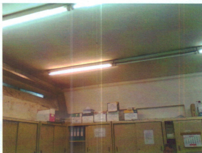
Ilustração 12 e 13: Evidências de humidade e falta de revestimento das paredes e tectos.
