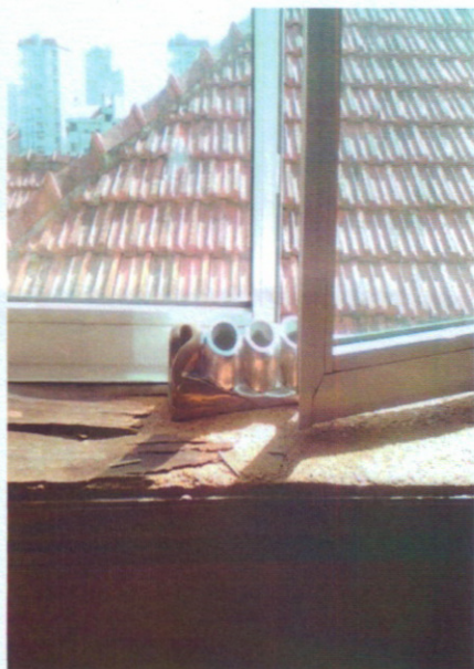
Ilustração 2: Caixilharias degradadas.
