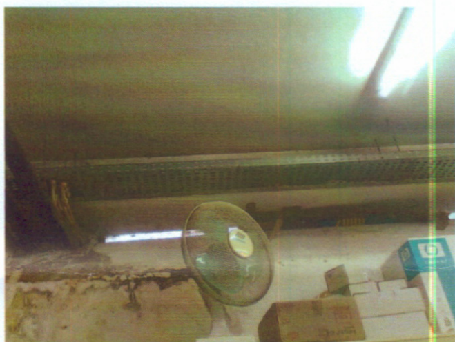
Ilustração 12 e 13: Evidências de humidade e falta de revestimento das paredes e tectos.
