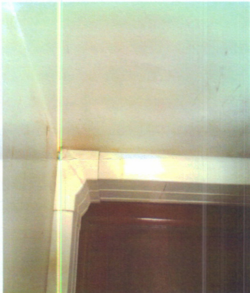
Ilustração 19, 20 e 21: Evidências de humidade e infiltrações.
